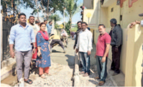
రోడ్డు పనులను పరిశీలిస్తున్న కార్పొరేటర్
